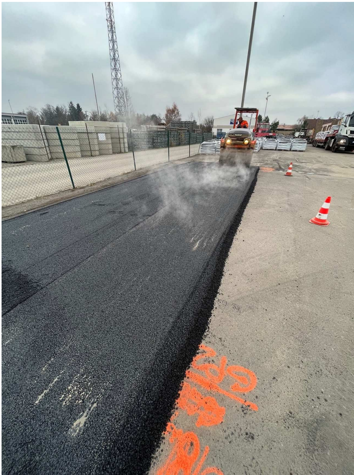
OBRÁZEK Č. 4 – HUTNĚNÍ OBRUSNÉ VRSTVY Z AC08
