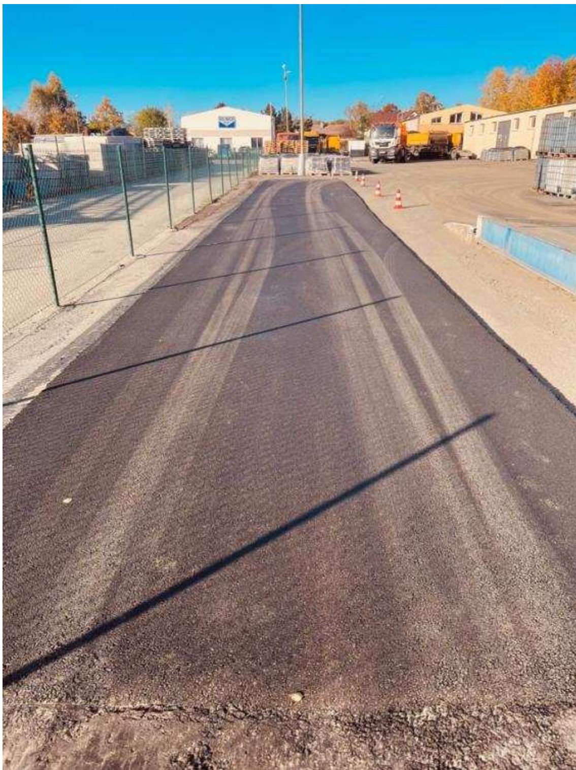
OBRAZEK Č. 2 – PO POKLÁDCE PODKLADNÍ VRSTVY Z ACO11+
